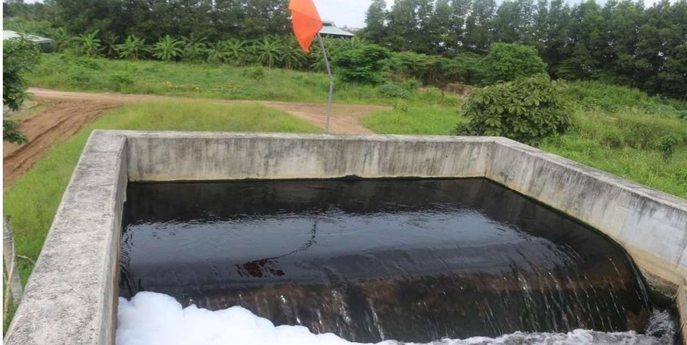
Hình 2 Ngăn tiếp nhận nước thải
